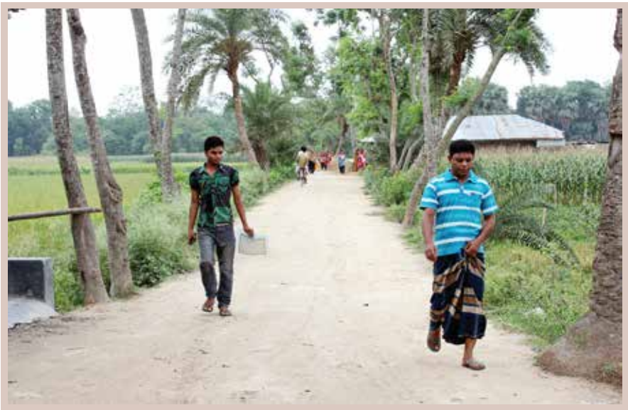
শিকদাড়ী বাজার হইতে মাঝগ্রাম ও খাঁমারগ্রাম এর কাঁচা সড়ক সংস্কার
