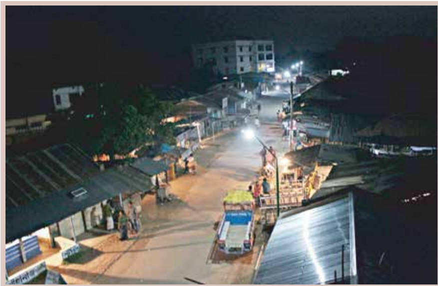
বাগমারা উপজেলার প্রতিটি বাজার আলোকিত করতে রোড লাইট স্থাপন
