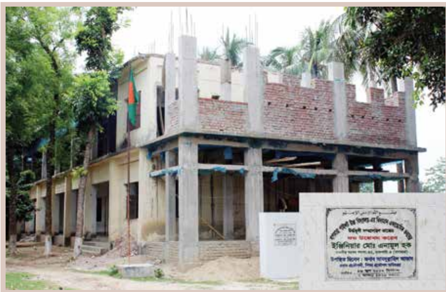
বাগমারা পাইলট উচ্চ বিদ্যালয় একাডেমিক ভবন
