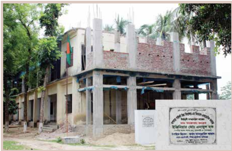
বাগমারা পাইলট উচ্চ বিদ্যালয় একাডেমিক ভবন
